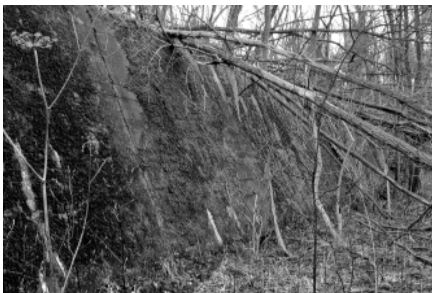
Abb. 2: Das Westwallbauwerk im Wald zwischen Berg und Hagenbach ist dicht von Moosen bewachsen. Hier befindet sich der bisher einzige Nachweis des Zarten Kleinschnabeldeckelmooses in der pfälzischen Rheinebene.
